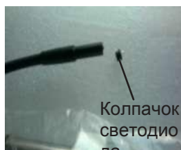
Фото 30 Замена лампы светодиода
